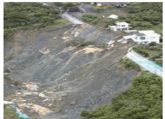
県道35号線土砂崩れ状況(6/12)
