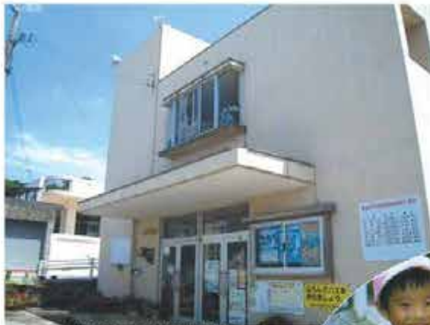
当銘公民館: 放送設備設置
