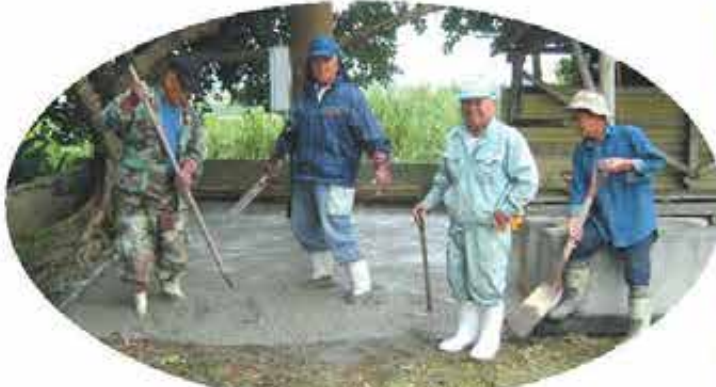
小城地区: 公民館広場休憩所改修
