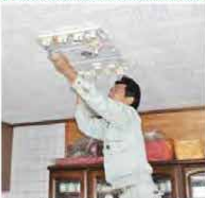
安全点検、蛍光灯を取り替える
